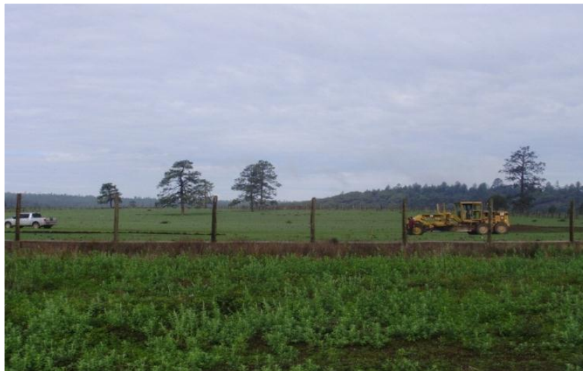
Figura 17. Zanja derivadora de escorrentía, para evitar encharcamiento dentro de la plantación (Foto: Celestino Flores López, 3 de julio de 2009).
