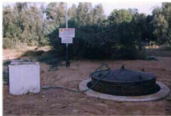
Figura No. 9. Ejemplo de digester hindú.
