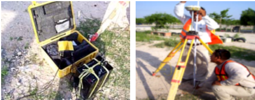
Instalación de antena maestra.
