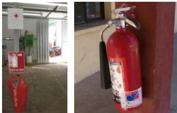
Extintores en área de campamento y oficinas.
