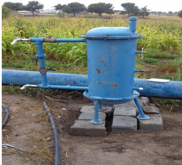
Figura 3.5. Rehabilitación del Filtro de Arena y Conexión de Adaptadores para Manguera.
