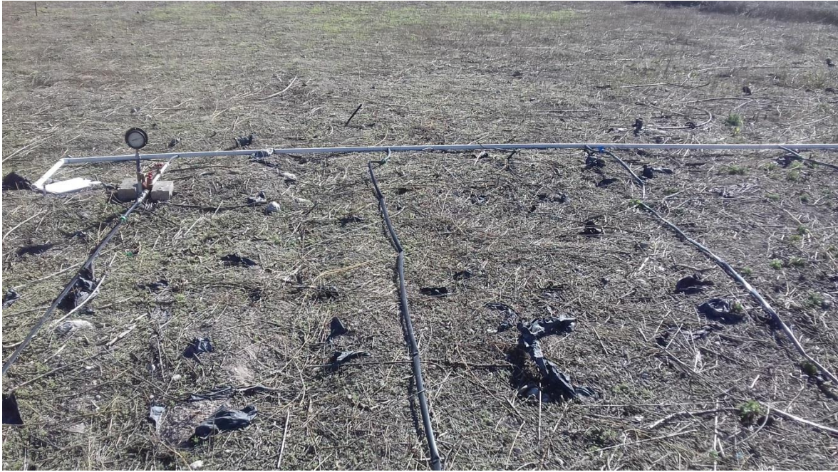
Figura 3.7. Tendido de Cinta de Goteo y Conexión al Maniful con Pendiente a Favor.
