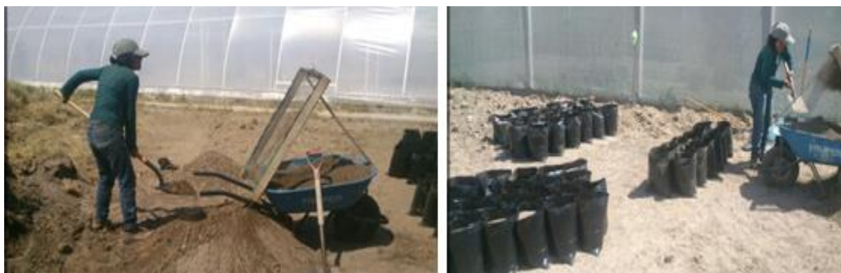
Figura 3.2 Limpieza del terreno, cribado de la arena y llenado de las bolsas. UAAAN-UL, 2015.
