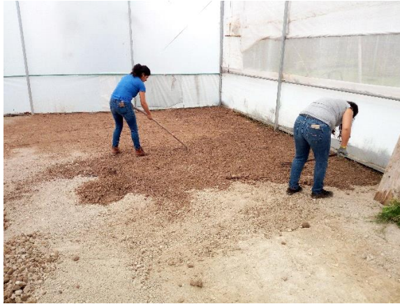
Imagen 6. Nivelación y preparación del terreno.
