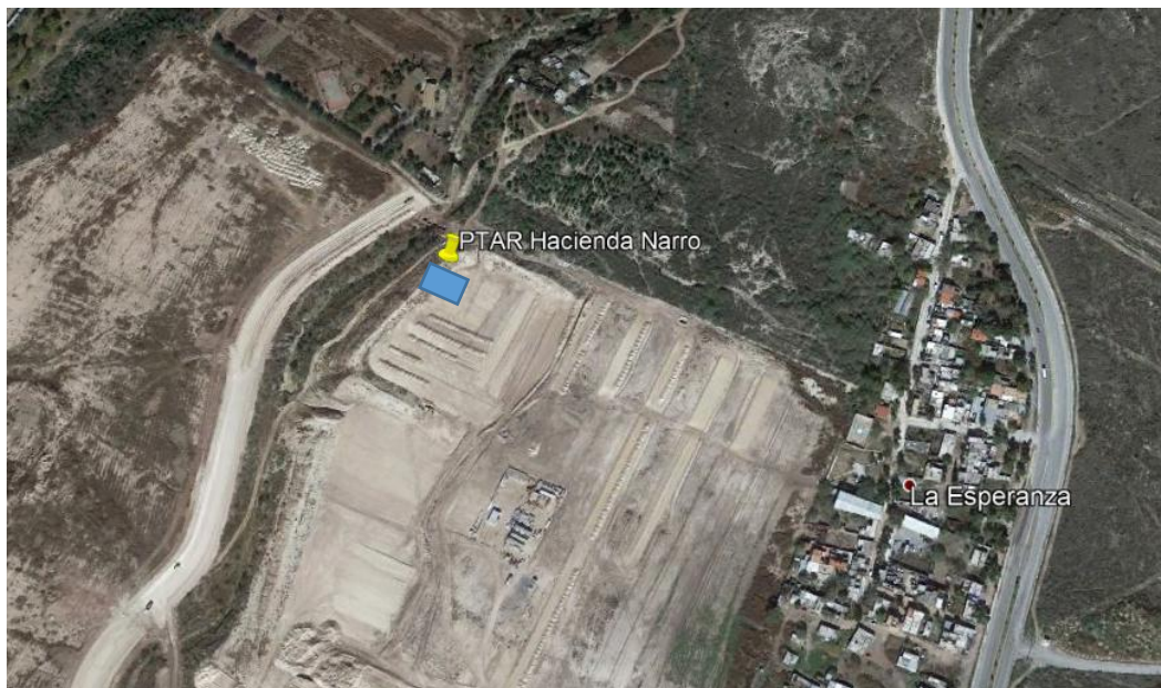
Figura 5. Localización geográfica PTAR-Hacienda Narro (Google Earth, 2016).
