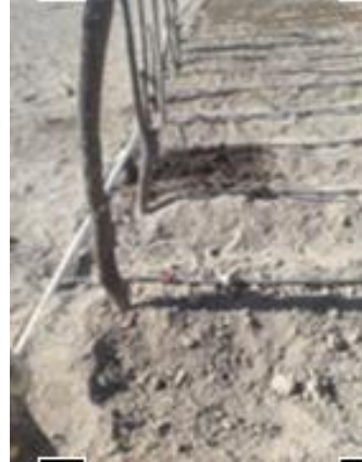
Figura 6. Instalación de líneas regantes.
