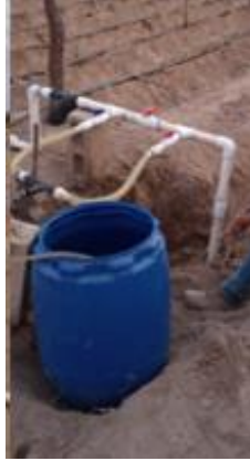
Figura 7. Instalación de manifold.
