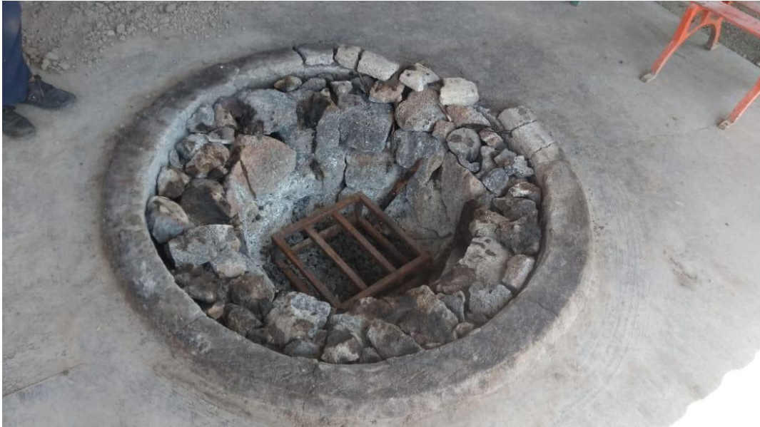
Ilustración 1: Horno tradicional de ladrillo y piedra para elaboración de barbacoa . Medio de calefacción: leña
