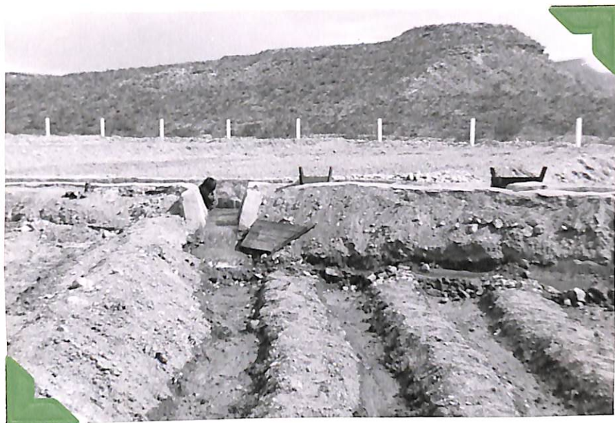
Foto No. 5. Riego de parcelas. Vease las Compuertas de retención y las de salida.
