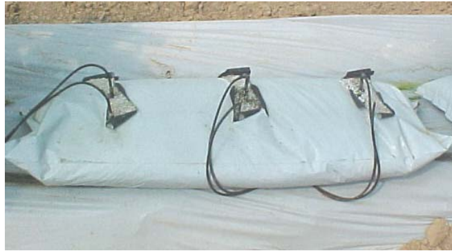
Fig. 3.2 Instalación de los Goteros en el Taco con Sustrato Perlita.
