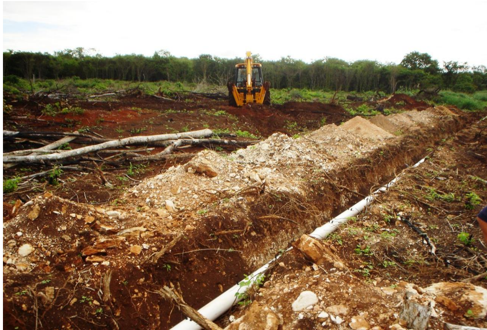
Instalación de Tubería de PVC
