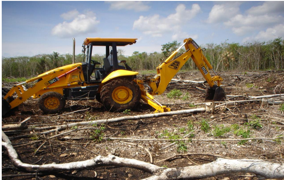
Desmonte y Limpieza del Terreno.
