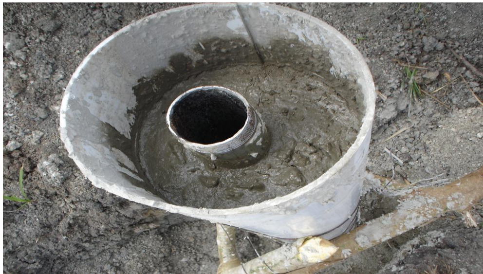
Colado para la Base del Hidrante o llave según sea el caso.
