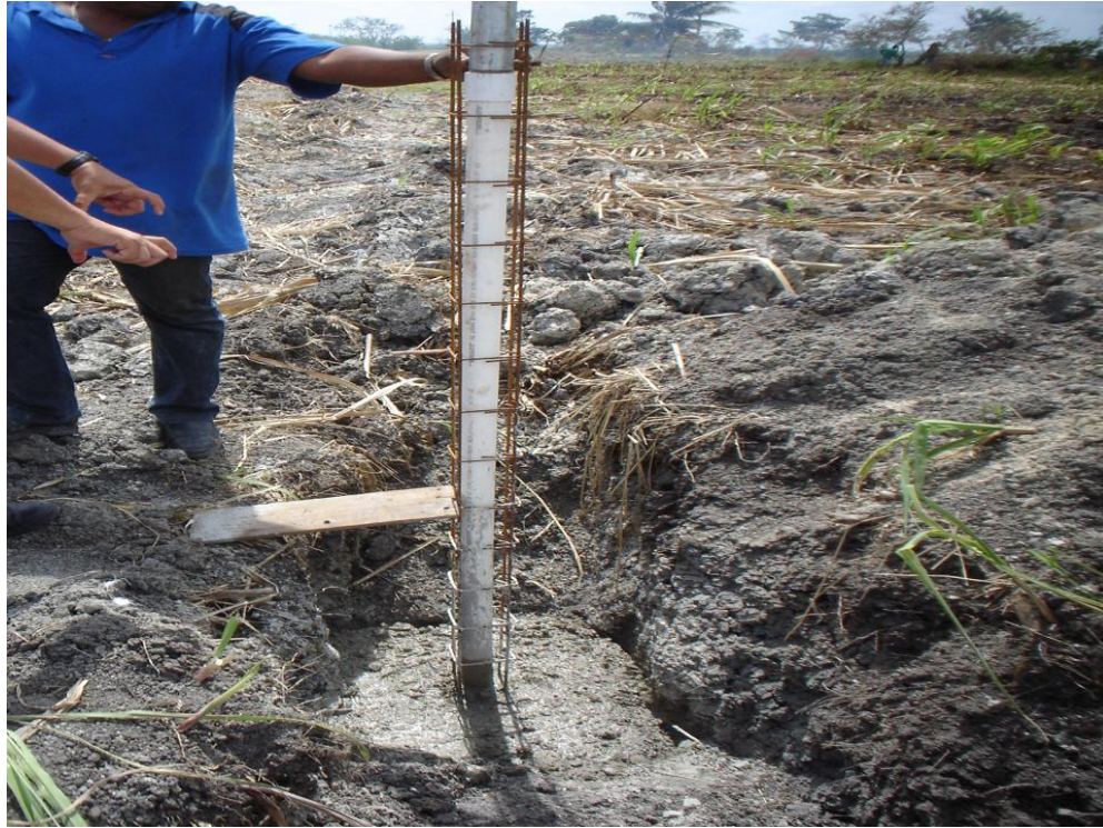
Colado de atraques
