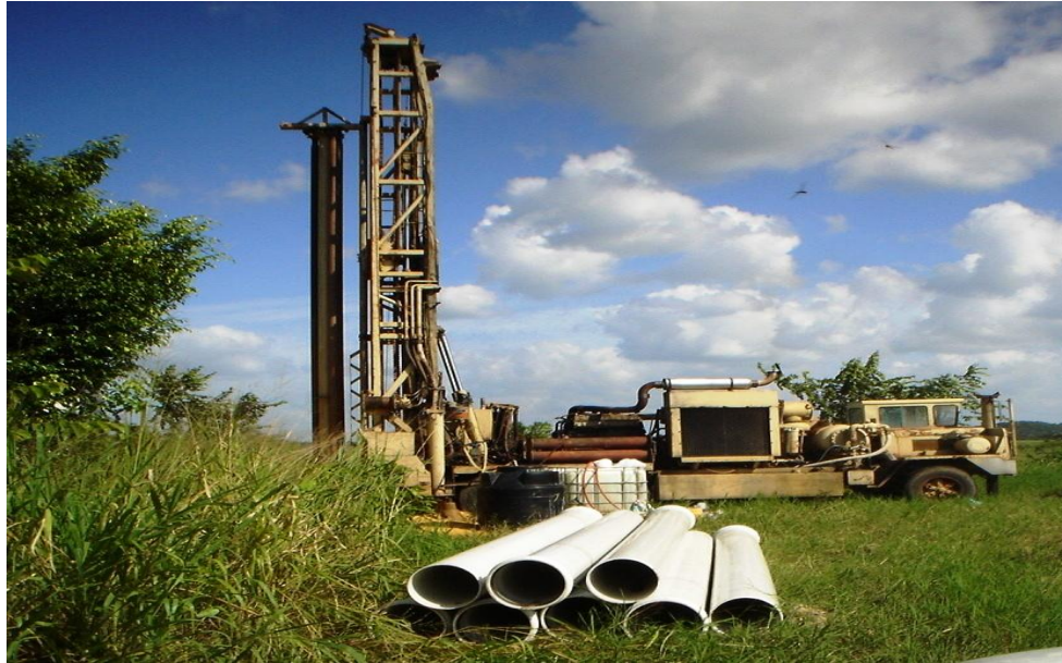
Perforación del Pozo
