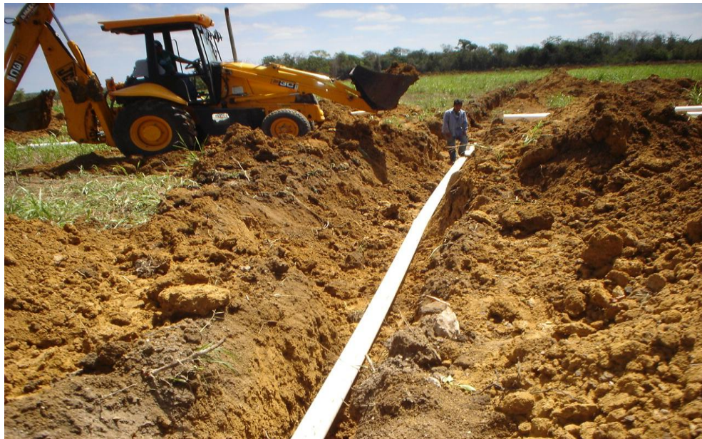
Instalación de tubería de PVC
