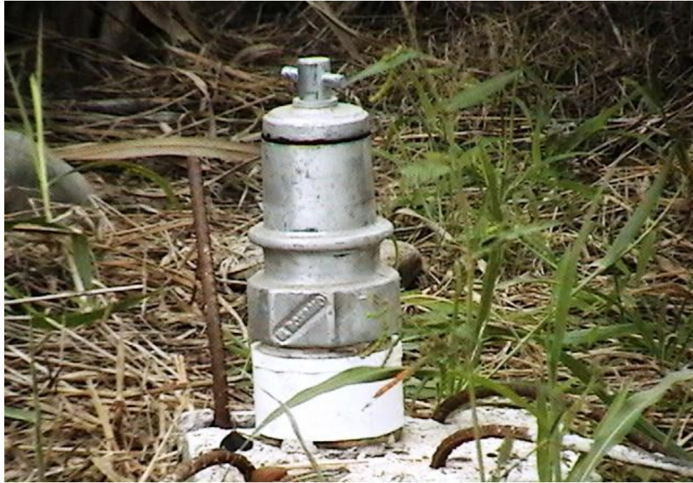
Válvula Hidrante ya Instalado.
