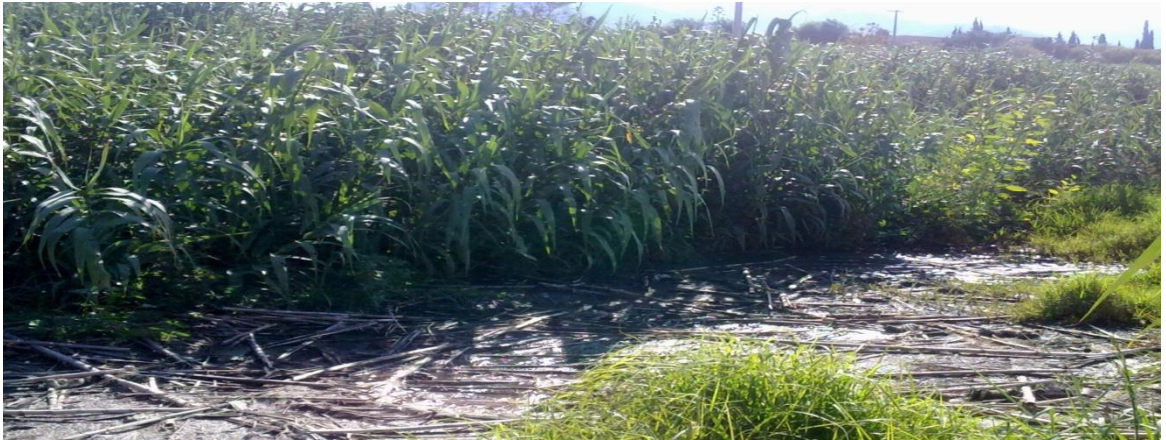
Figura 4. Estanque de sedimentación.
