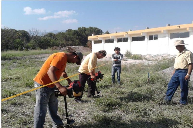
Apendice 1b. Apertura de cepas de manera mecánica con un ahoyador.
