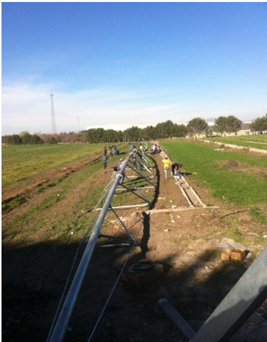
Figura 20. Vista preliminar del ensamble de una armadura
