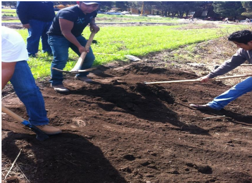
Figura 9. Eliminación de canaletas de concreto para despeje de la ruta
