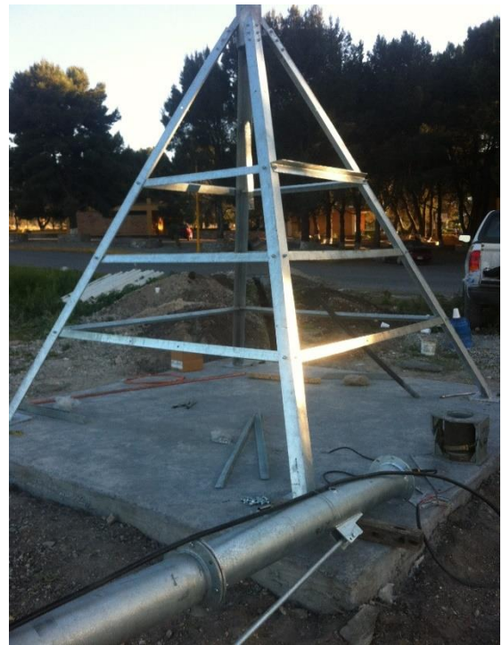
Figura 15. Instalación y terminación del punto pivote
