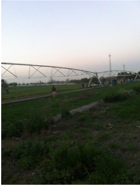
Figura 25. Ensamble de la última torre
