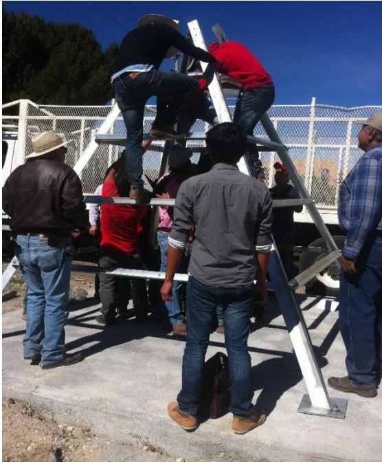
Figura 14. Ensamble del punto pivote
