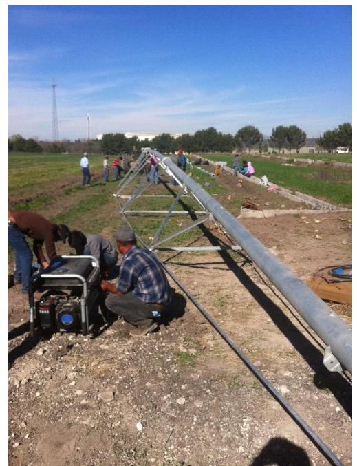
Figura 19. Ensamble estructural de la armadura de arranque
