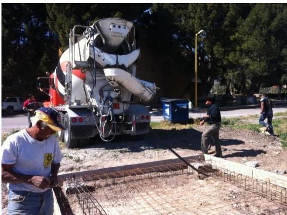
Figura 11. Vaciado de concreto para la base pivote
