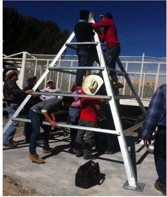
Figura 14. Ensamble del punto pivote
