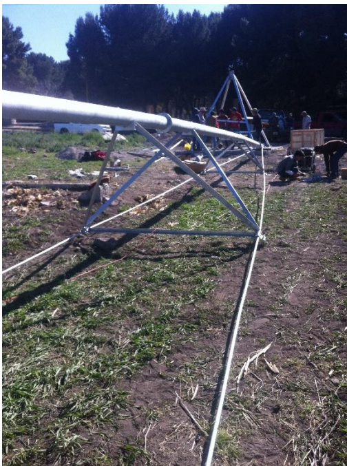
Figura 19. Ensamble estructural de la armadura de arranque
