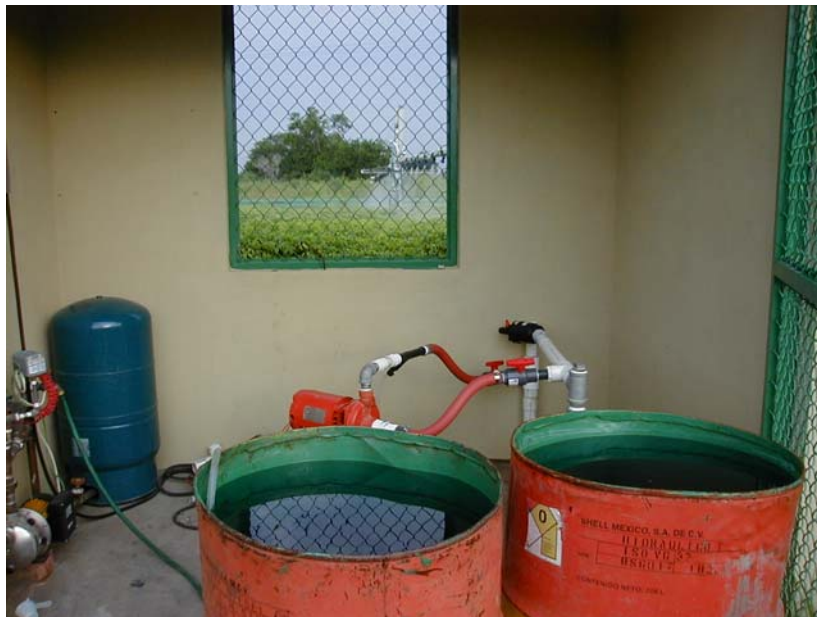
Imagen 23. Sistema de fertigación
