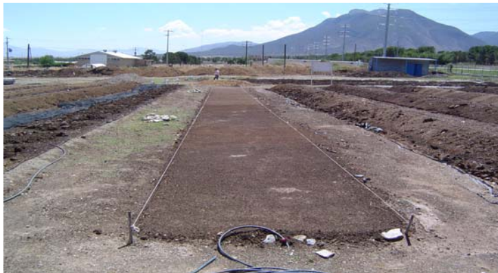
Figura 10. Acondicionamiento del área para instalar el plástico en el lecho
