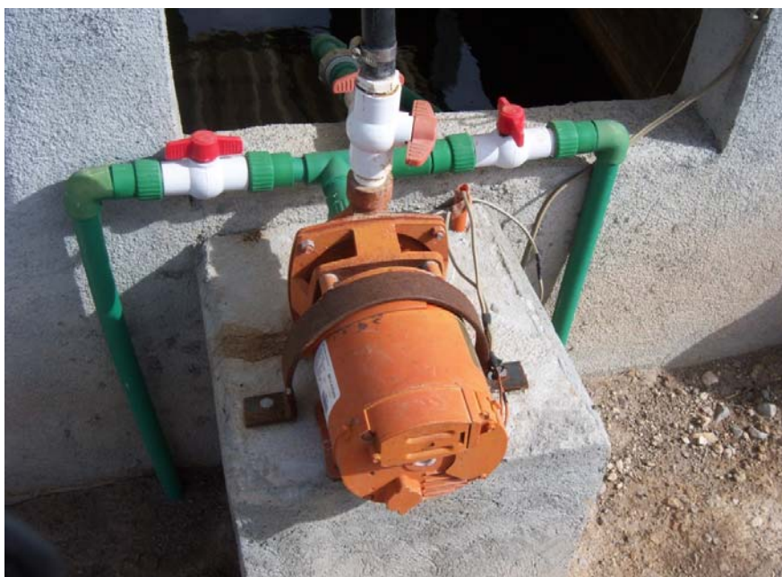
Figura 17. Sistema de bombeo para oxigenar y llenado de contenedores para venta del humus líquido
