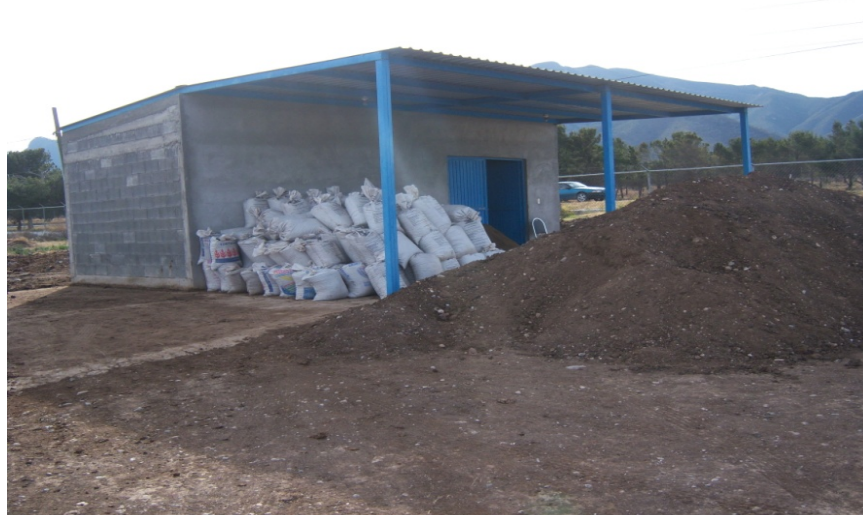
Figura 19. Área de cribado, envasado y almacén de sólidos
