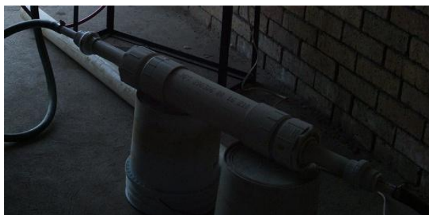
Figura 3.15. Conexión de mangueras de entrada.
