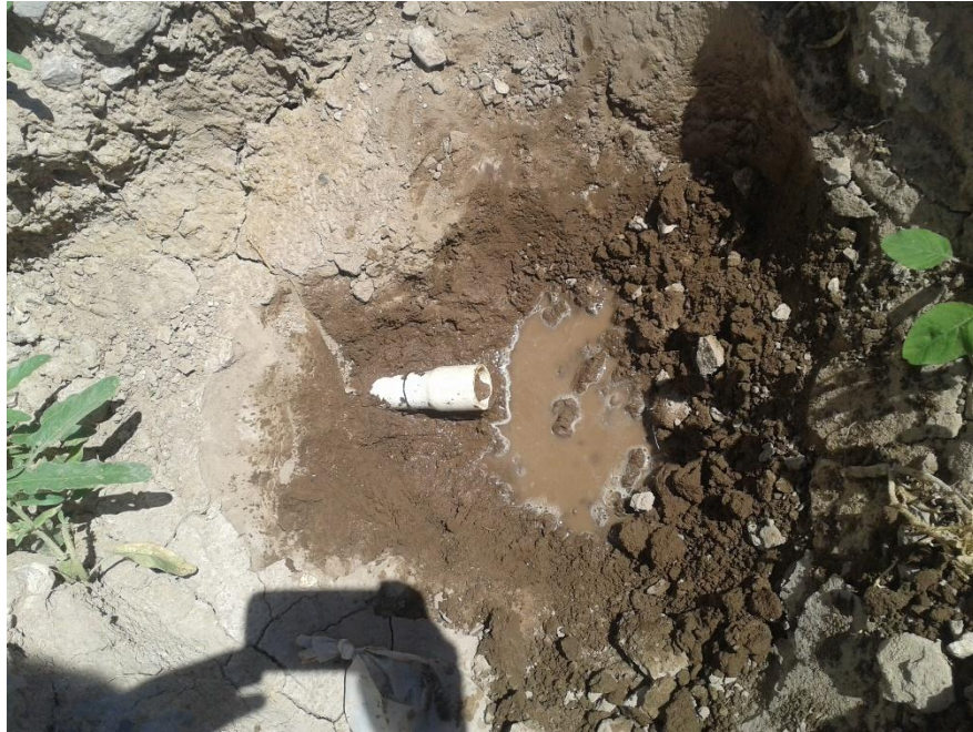
Figura 4.4. Salida de drenaje.
