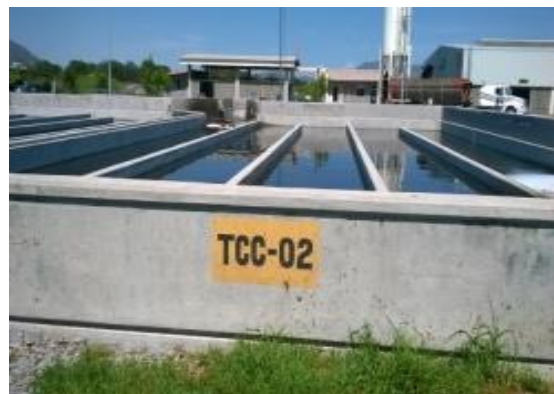
Figura 4.1.1. Tanque de Cloración.
