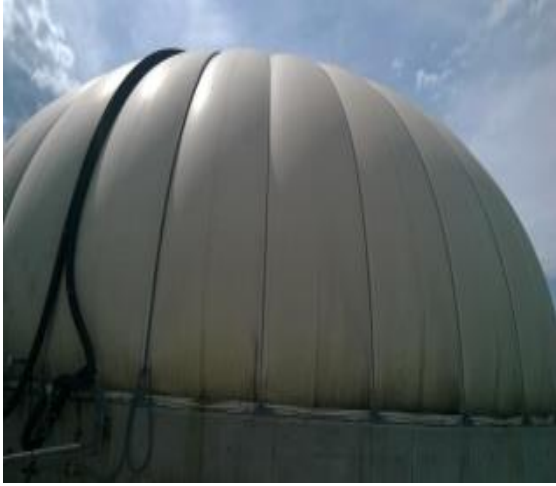
Figura 6.5.1. Gasómetro.
