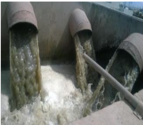
Figura 2.3.1. Turbulencia en Desarenador.
