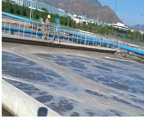
Figura 3.2 TQS de Aireación.
