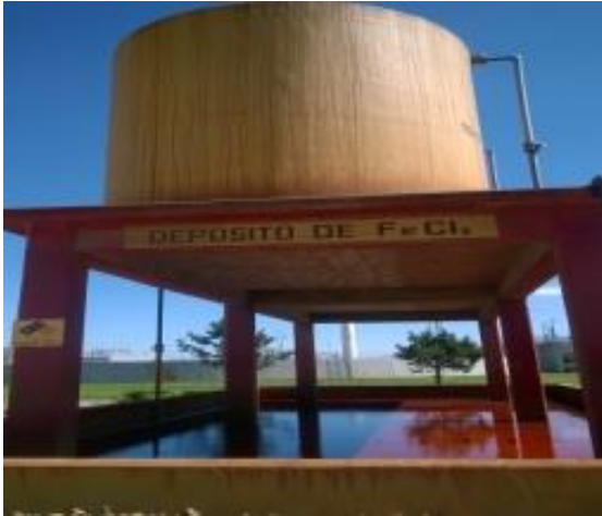
Figura 2.4.1 Depósito de \text{FeCl}_3 .
