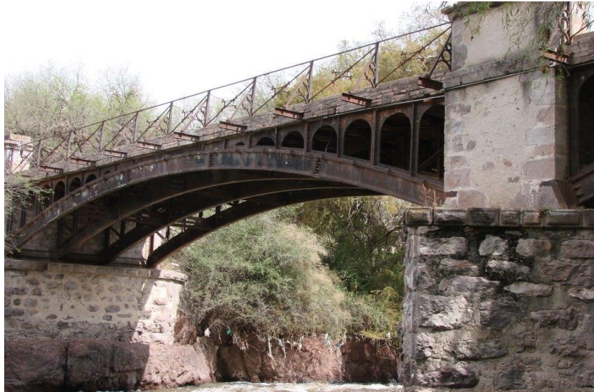
Figura 2. Puente de fierro (puente viejo) Tasquillo
