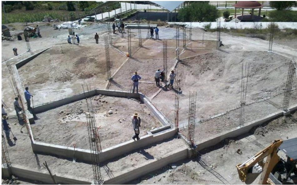
Figura 15. Construcción de la iglesia ( primera etapa)
