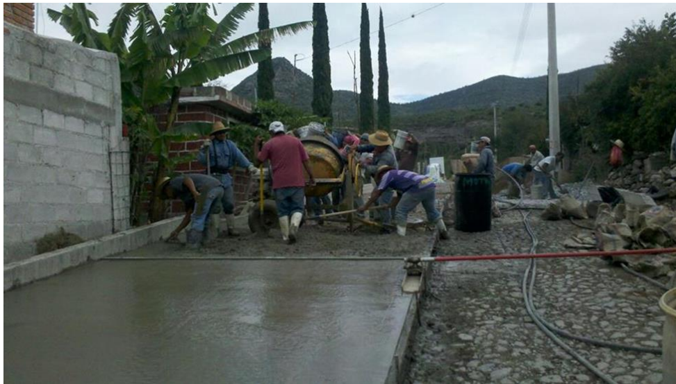
Figura 14. Pavimentación de calles como obras del año, ampliación de metas
