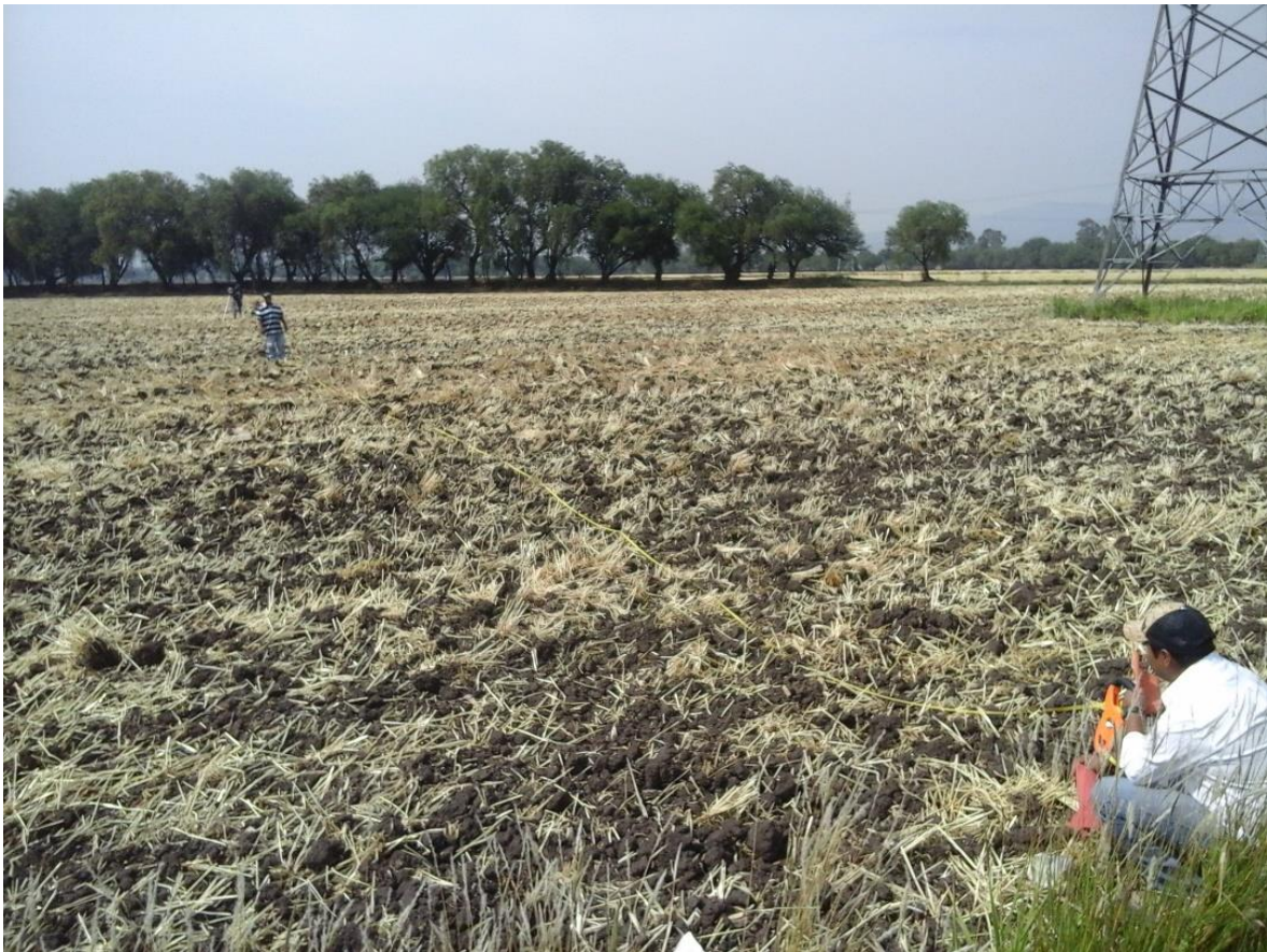
Figura 10.-Trazo de cuadrícula para proyecto de nivelación.
