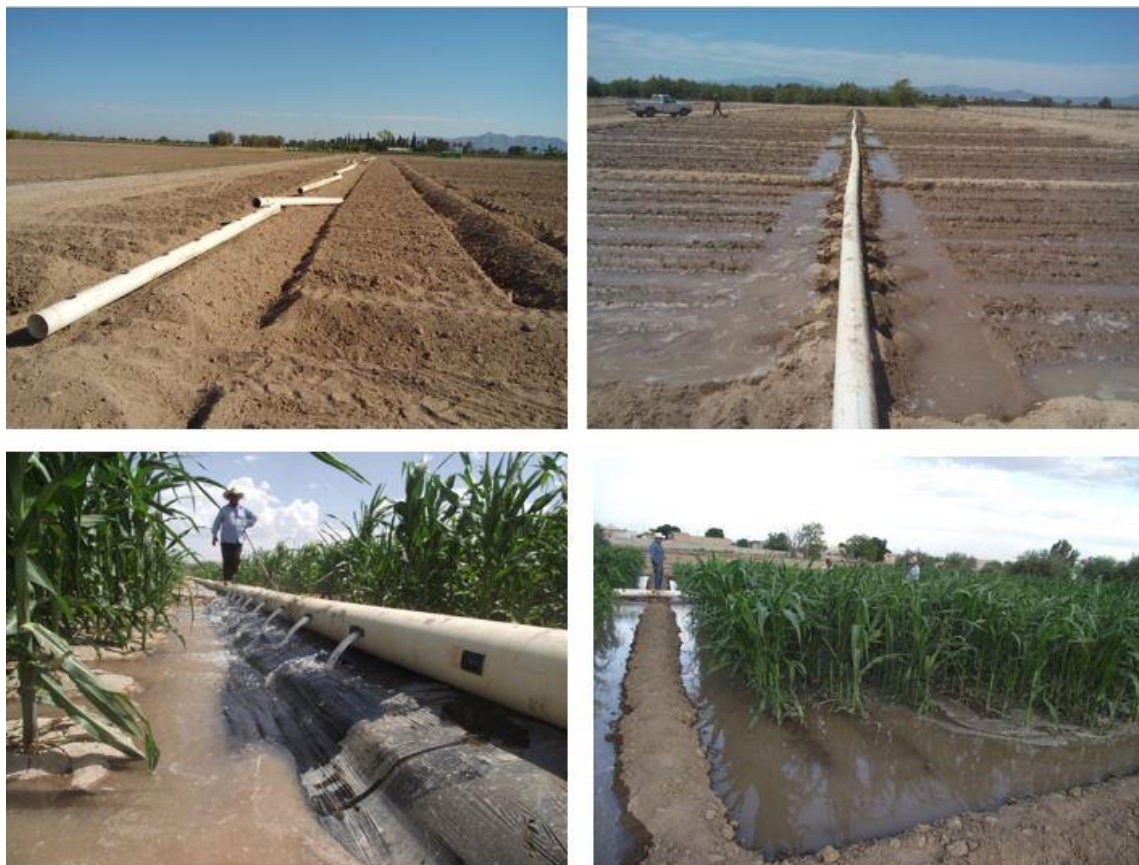
Figura 20. Colocación de la tubería para la conducción de agua y riego por multicompuertas, riego de pre siembra, primer y segundo auxilio (orden del reloj).
