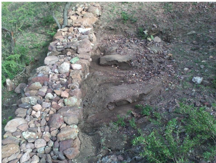
Figura 19. Retención de azolves y filtración de agua en presa de piedra acomodada Ejido Trancoso, Trancoso, Zacatecas (Fotografía tomada por Santiago Aguilar, 2013).
