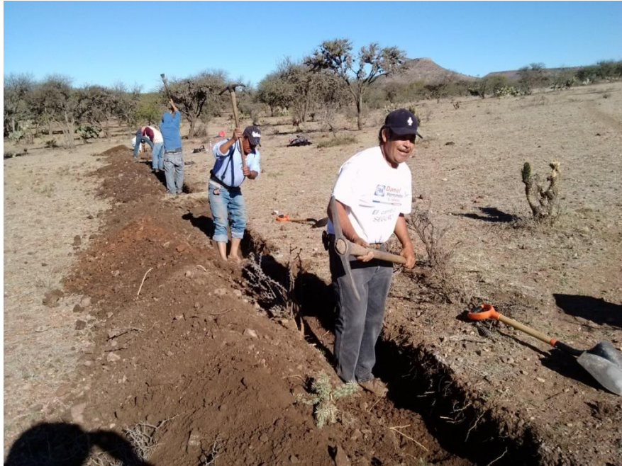
Figura 12. Zanjas bordo construidas manualmente Ejido Trancoso, Trancoso, Zacatecas (Fotografía tomada por Santiago Aguilar, 2013).
