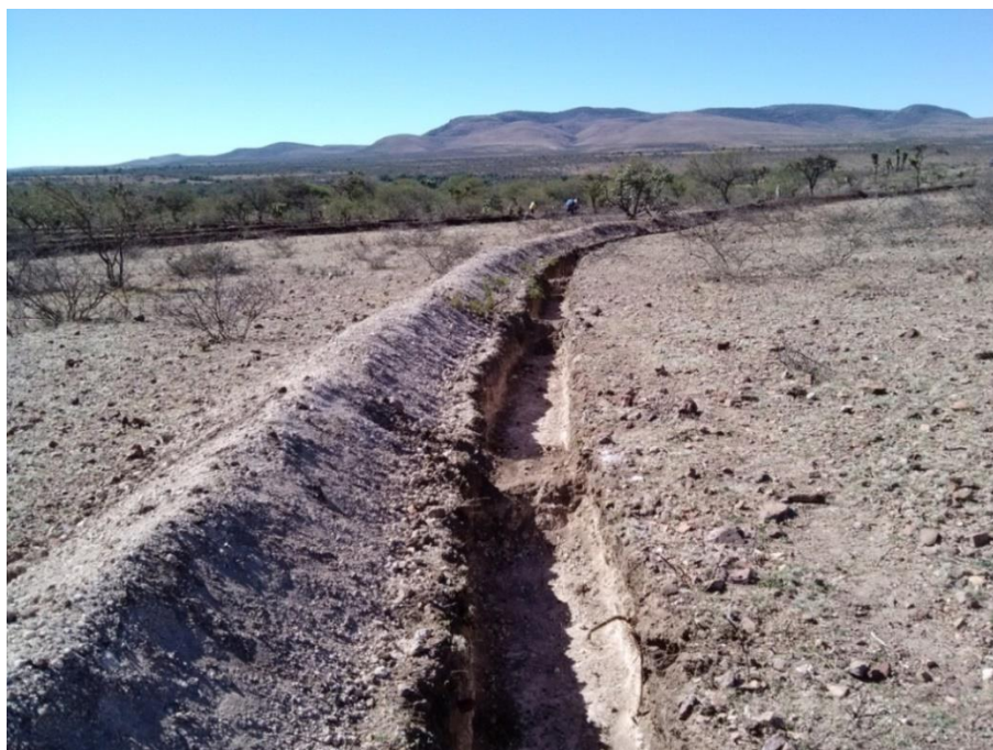
Figura 13. Construcción de zanja bordo manual en curvas a nivel con dique divisorio cada 5 metros Ejido Trancoso, Trancoso, Zacatecas (Fotografía tomada por Santiago Aguilar, 2013).
