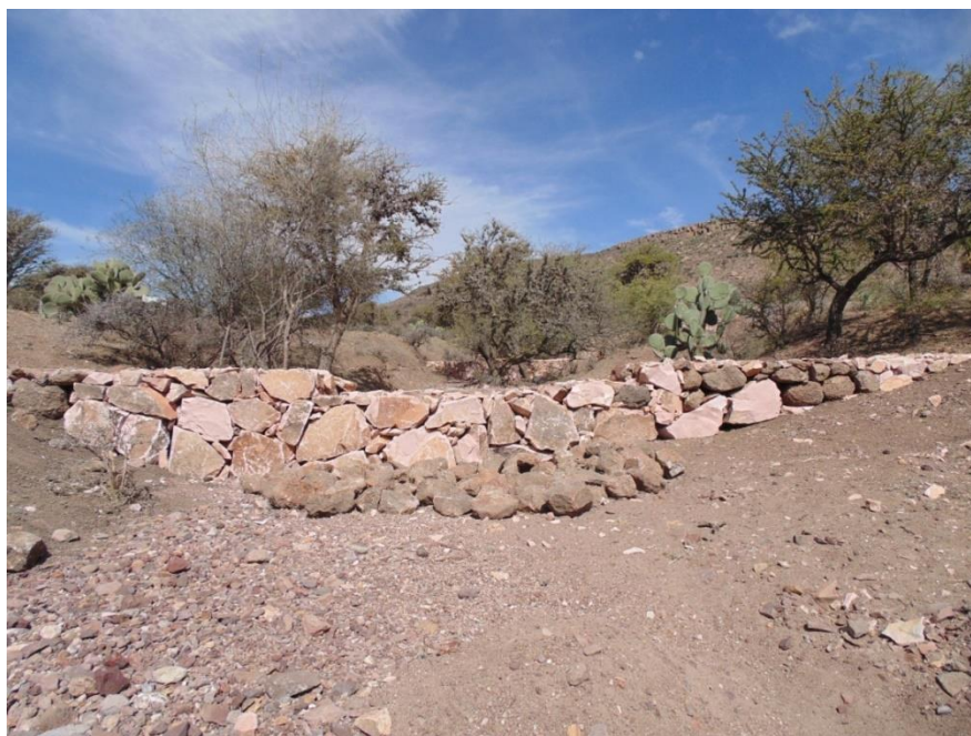
Figura 18. Construcción de presas de piedra acomodada, Ejido Trancoso, Trancoso, Zacatecas (Fotografía tomada por Santiago Aguilar, 2013).
