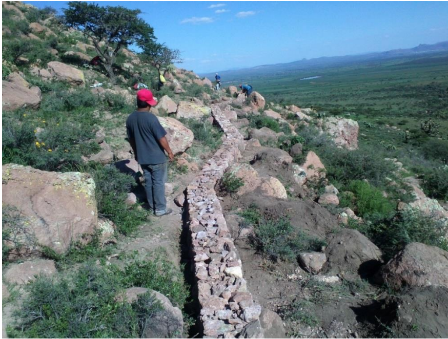
Figura 9. Barrera de piedra acomodada en la parte mas alta del predio Ejido Trancoso, Tancoso, Zacatecas (Fotografía tomada por Santiago Aguilar, 2013).
