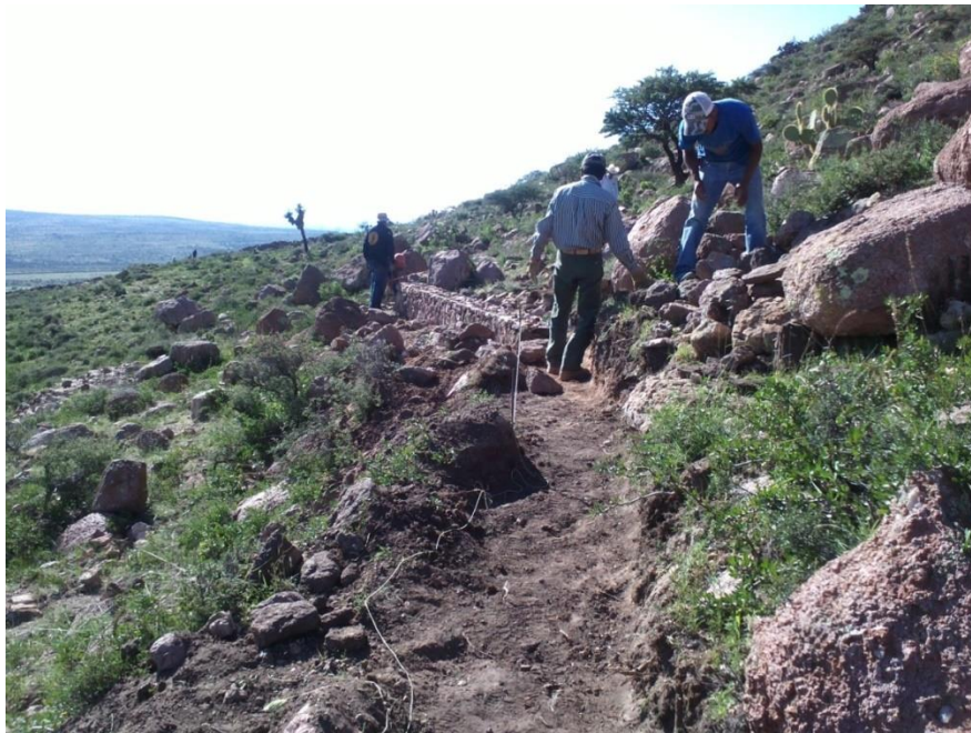
Figura 8. Preparación para cimentar y dar estabilidad a la barrera y acomodo de piedra Ejido Trancoso, Trancoso, Zacatecas (Fotografía tomada por: Santiago Aguilar, 2013).
