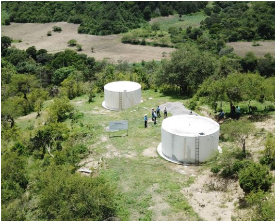
OBRA: Tanque de almacenamiento. LUGAR: Rancho Nuevo Pequeño, Tula, Tamaulipas. FOTOGRAFÍA: Lic. Sergio Salvador García Rivera
