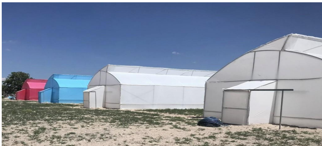
Figura 2. Invernaderos con cubiertas de polietileno difuso de alta densidad de colores rojo, azul, blanco lechoso y blanco comercial, instalados en la propiedad denominada rancho Nueva Rosita, Cedral, San Luis Potosí, México.
