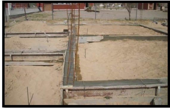
Elaboración de cimientos
