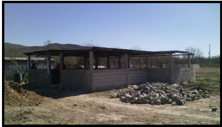
Posta porcina a un 80 % de su avance
