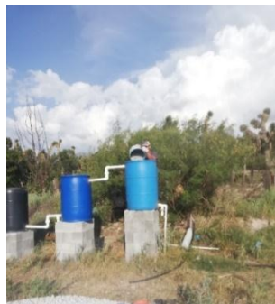
Figura 31.- Llenado de los toneles con grava.
