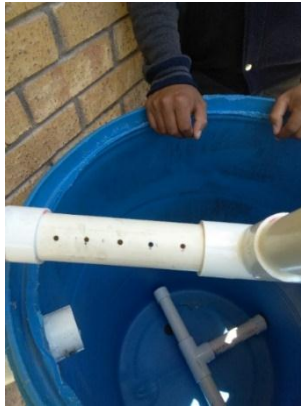
Figura 25.- Posición, forma y perforaciones de los drenes.
