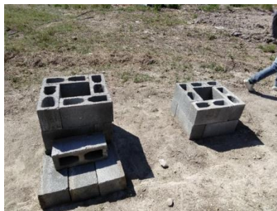
Figura 23.- Posición de los blocks en la construcción del pilar.
