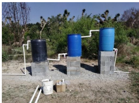
Figura 28.- Humedal artificial terminado.
