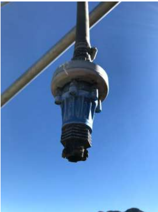
Figura 20.- Bajante, contrapeso y regulador de presión.
