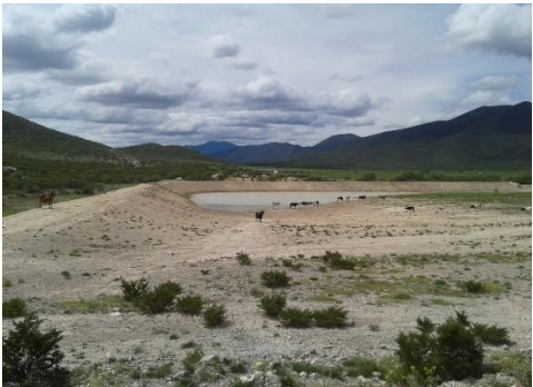
Imagen 18. Bordo de cortina de tierra compactada para abrevadero con zampeado en seco y obras de toma. Bordo de tierra sin zampeado
