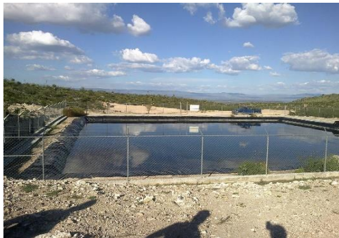
Imagen 29. Obras para la captación de agua para uso doméstico: Olla de agua en el ejido El Tunalillo y Aljibe en el ejido La Zacatera
