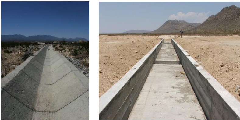
Imagen 31. Tipos de canal para la conducción de agua hacia las obras de almacenamiento (Ollas y Aljibes)
