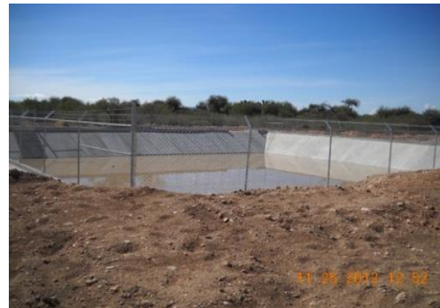
Imagen 29. Obras para la captación de agua para uso doméstico: Olla de agua en el ejido El Tunalillo y Aljibe en el ejido La Zacatera
