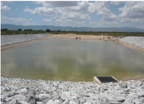
Imagen 18. Bordo de cortina de tierra compactada para abrevadero con zampeado en seco y obras de toma. Bordo de tierra sin zampeado
