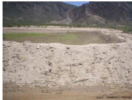
Imagen 17. Acciones que implican movimiento de tierra: bordería de entarquinamiento en el municipio de Viesca
