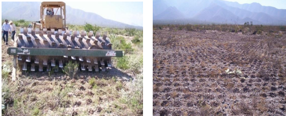
Imagen 9. Paso de Rodillo aireador para la rehabilitación de agostaderos
