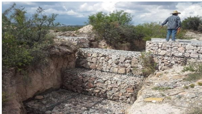
Imagen 30. Obra derivadora de escurrimientos a base de gaviones
