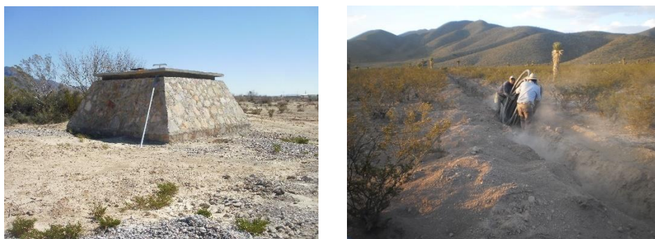
Imagen 10. Construcción de infraestructura para el manejo de agua: Pila de mampostería y línea de conducción
