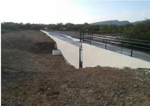
Imagen 20. Pequeñas presas de concreto con galería filtrante y obra de toma
