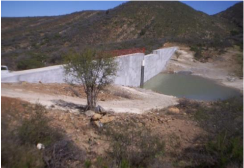
Imagen 19. Pequeña presa de mampostería con galería filtrante y obra de toma
