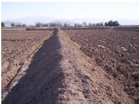
Imagen 17. Acciones que implican movimiento de tierra: bordería de entarquinamiento en el municipio de Viesca
