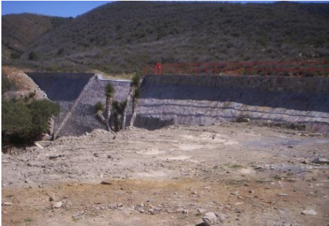
Imagen 19. Pequeña presa de mampostería con galería filtrante y obra de toma
