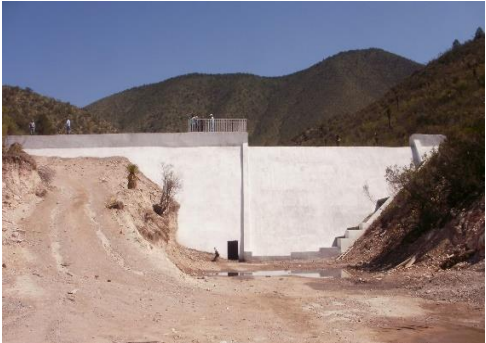
Imagen 20. Pequeñas presas de concreto con galería filtrante y obra de toma
