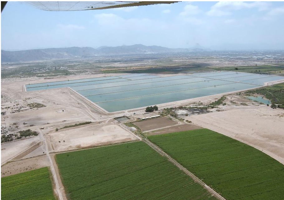
Figura 5. Vista aérea de planta tratadora de aguas SIMAS
