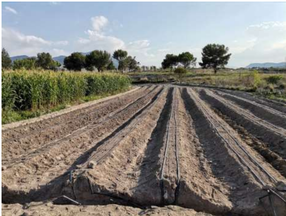
Imagen 20 Conexión de cintillas de ambas unidades
