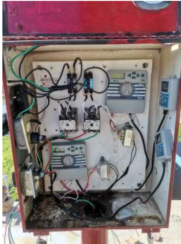
Imagen 28 Armado de arrancador y controlador de las unidades de riego
