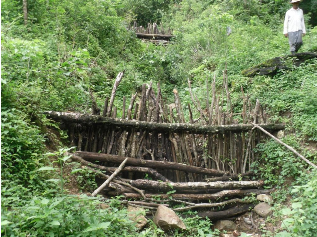
Figura 4. Presas de Ramas en el Ejido el Vergel.
