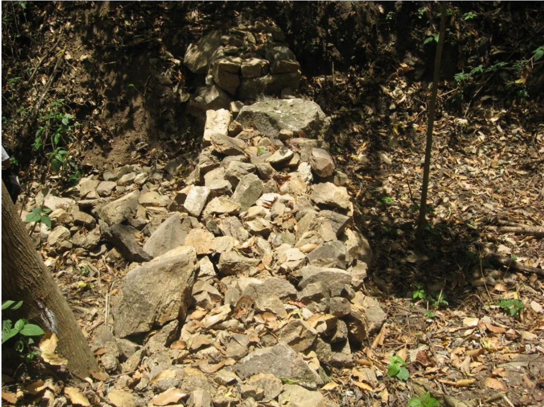
Figura 5. Presas de Piedra Acomodada.
