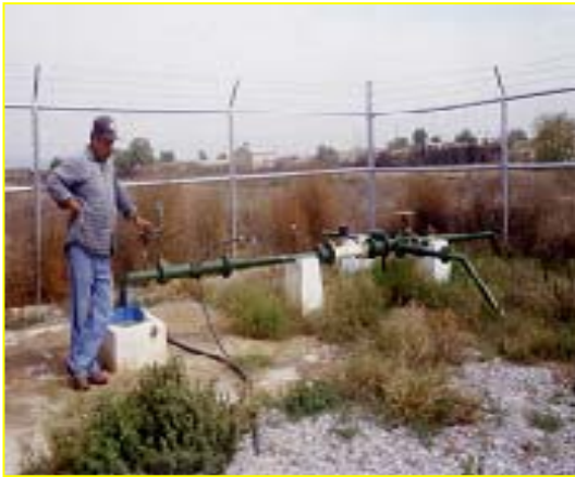
Perforación de pozo para agua potable ejido San Ignacio
