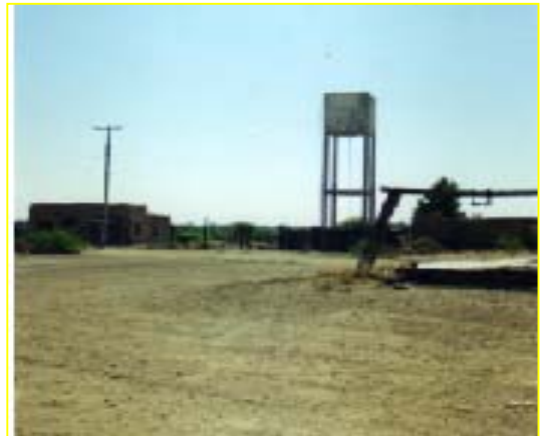
Tanque elevado para almacenamiento de agua potable El Panal
