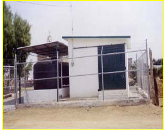
Planta de osmosis inversa para purificar el agua ej. San Ignacio
