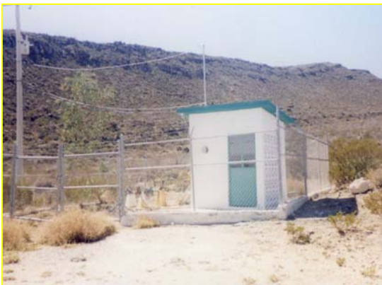
Perforación de pozo para agua potable ej. Fraustro
