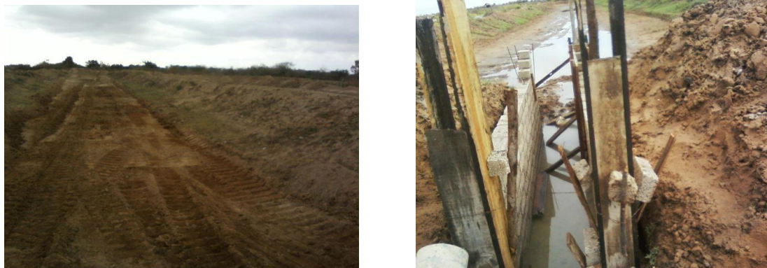
Figura 5. Estanque y compuertas de producción.
