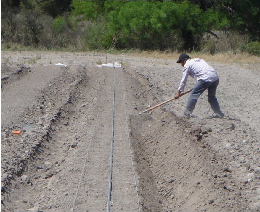
Figura A3. Instalación del sistema de riego y acolchado.
