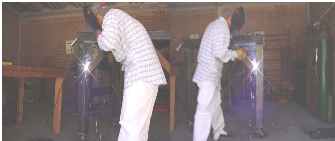
Figura 3.16 Últimos cordones de soldadura en la estructura.
