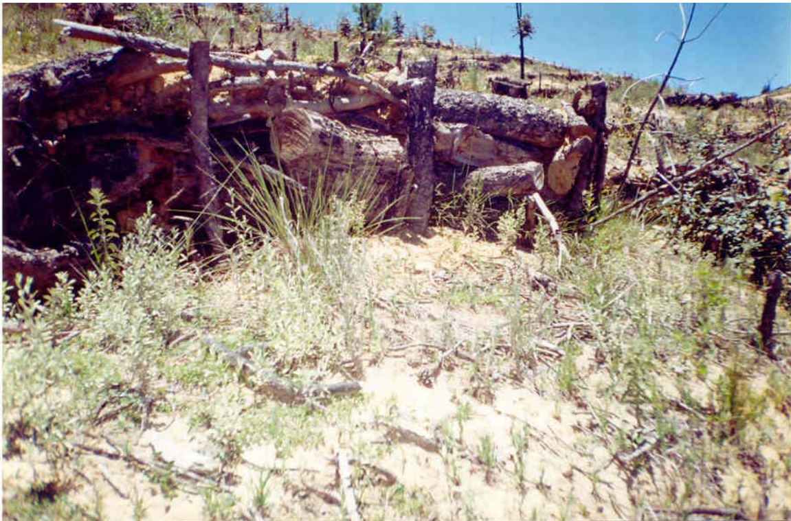
Figura 13. Detalle de la construcción de terrazas de formación sucesiva con ramas
