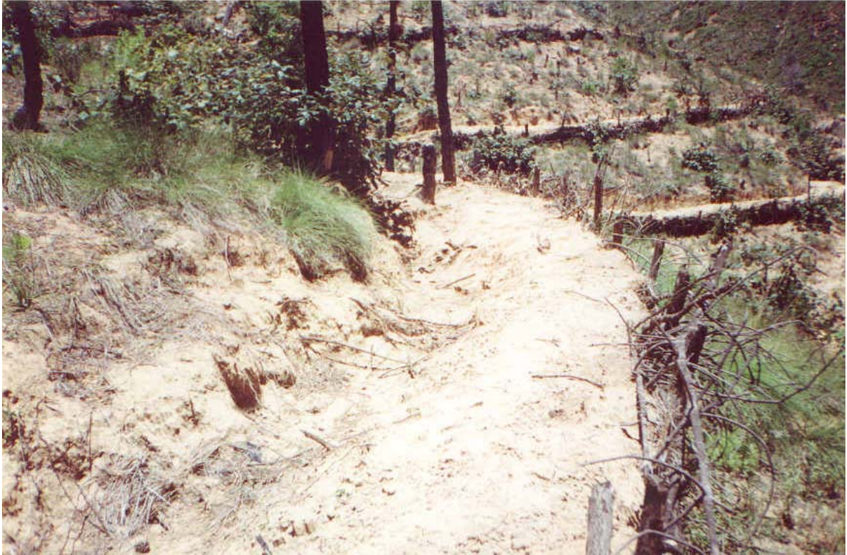
Figura 17. Vista de una terraza a dos años de su construcción
