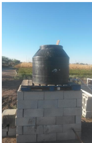
Figura 4. Tanque rotoplax (500 L) para el mezclado y alimentación de los digestores.
